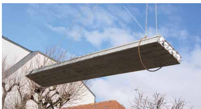
Pose de dalle alvéolaire précontrainte
