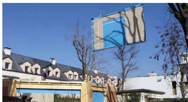
Pose des murs R+1
